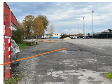
Accès au parking
